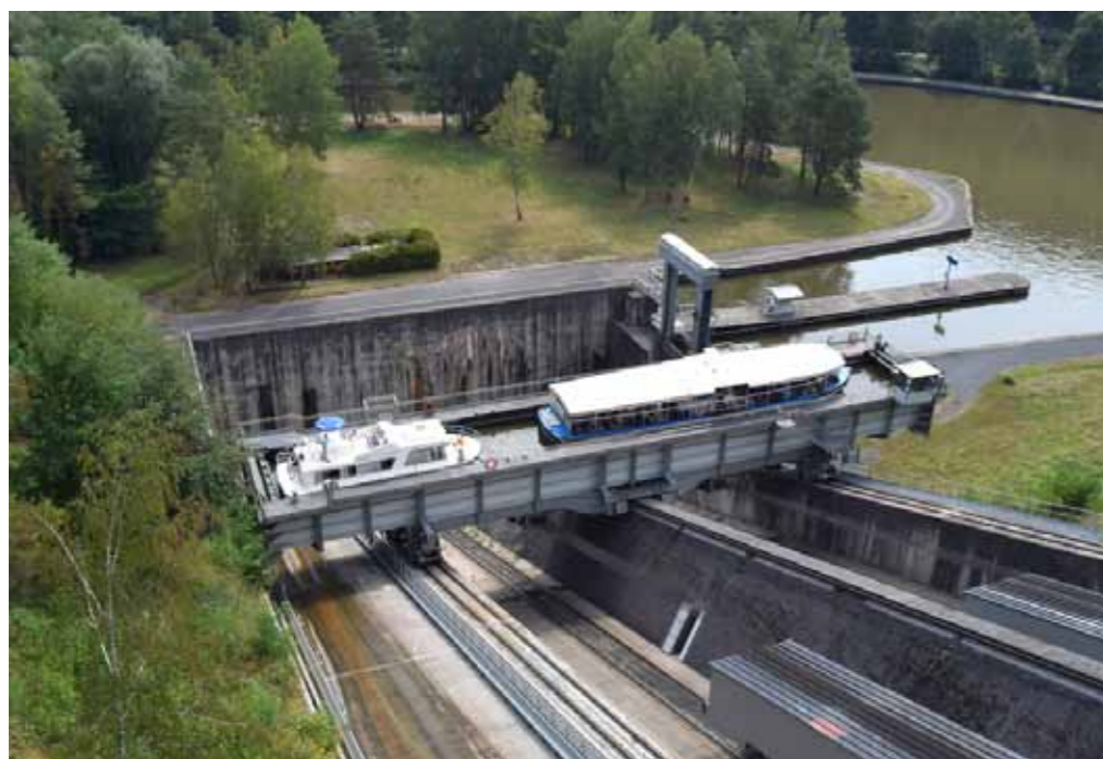
Overzicht van het indrukwekkende complex
